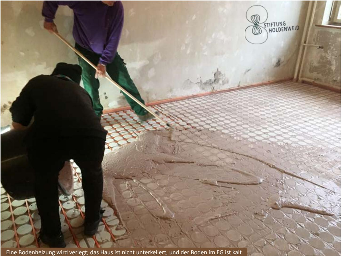
Eine Bodenheizung wird verlegt; das Haus ist nicht unterkellert, und der Boden im EG ist kalt
