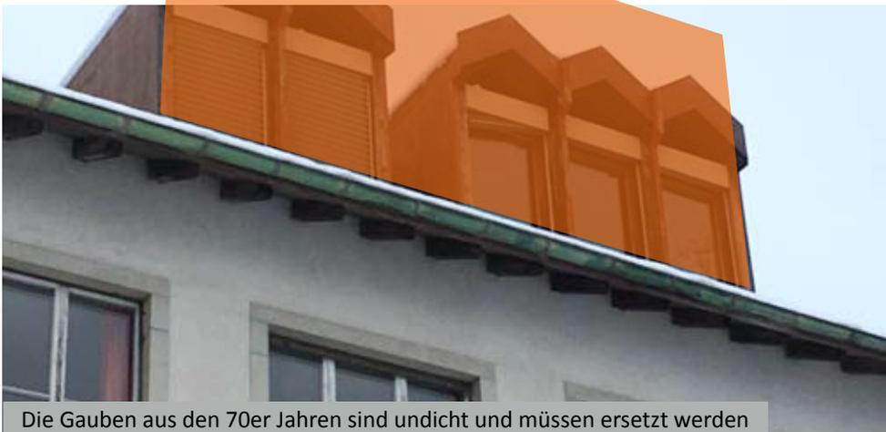
Die Gauben aus den 70er Jahren sind undicht und müssen ersetzt werden
