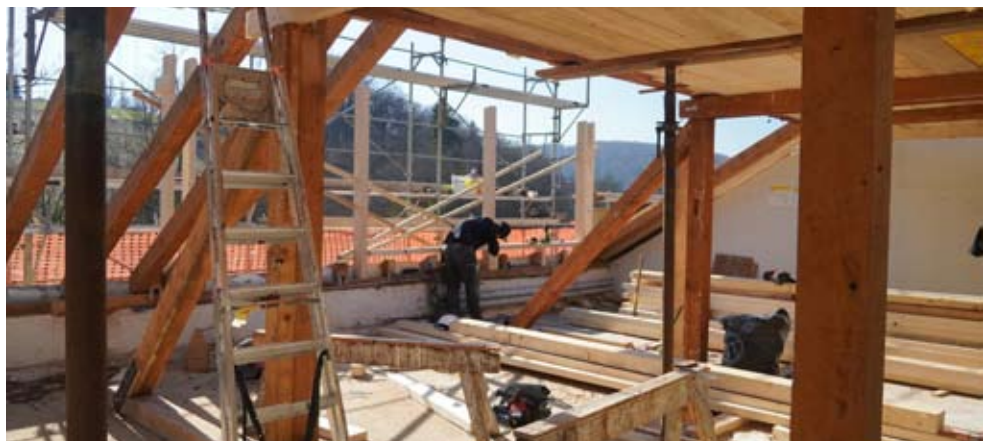
Die Dachsanierung wurde durch die Claire Sturzenegger-Jeanfavre Stiftung ermöglicht
