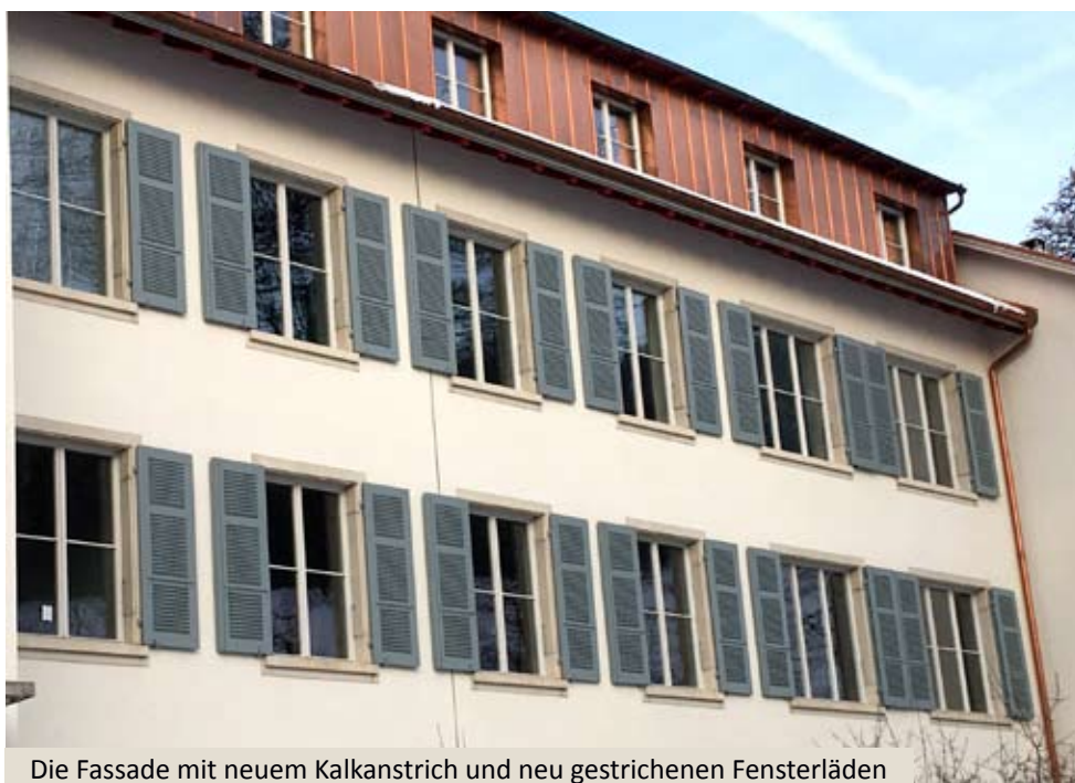
Einsatz neuer Fenster im Trakt A, B und C
