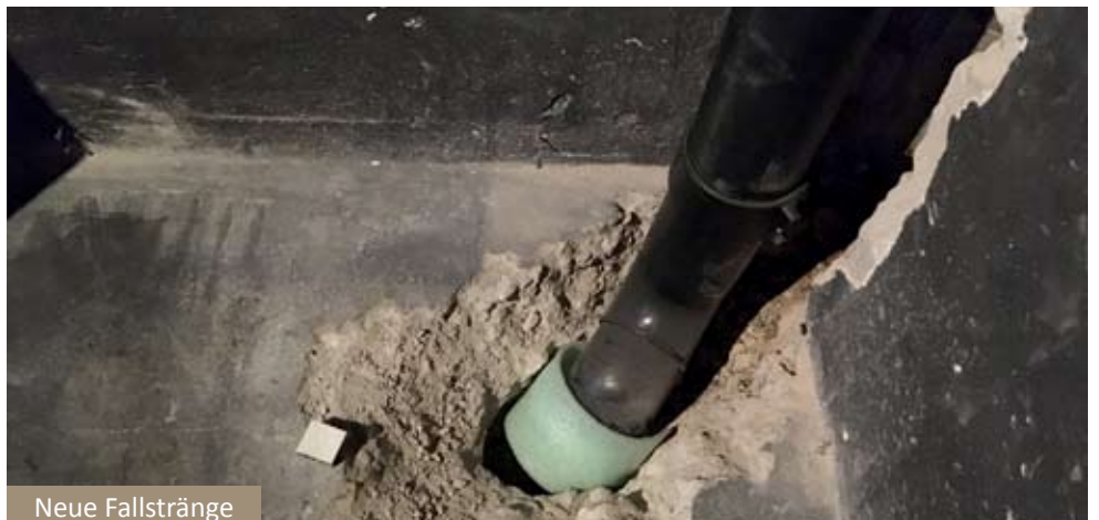
Die neuen Frischwasserzuleitungen
