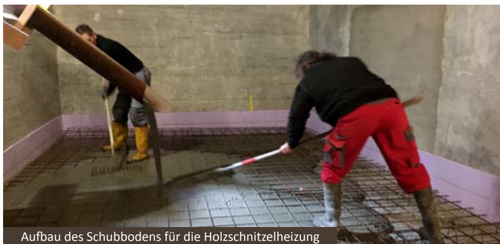
Sämtliche alten Heizleitungen müssen entfernt werden
