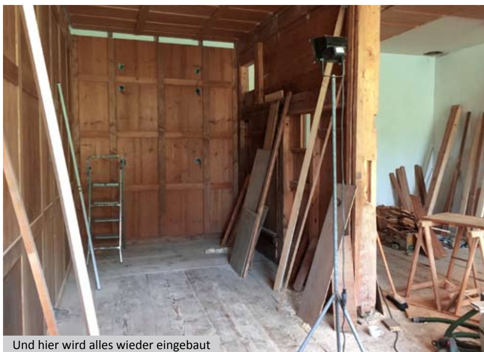
Die Bodenbretter wurden mit dem Kran durchs Fenster gehievt
