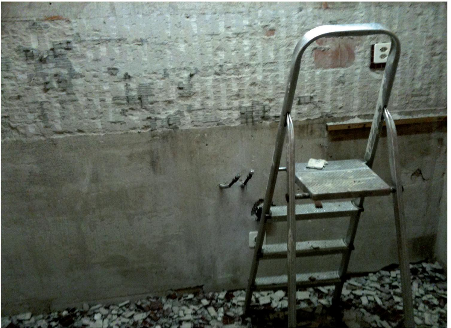
Die Küche haben wir vollständig abgespitzt, da sie sich in einem äusserst desolaten Zustand befand. Es mussten neue elektrische Leitungen gezogen werden.
