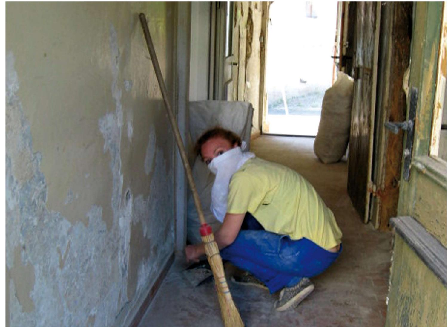
Die Bruchsteinmauern des Pächterhauses mussten teilweise komplett abgeklopft- und erneuert werden.
