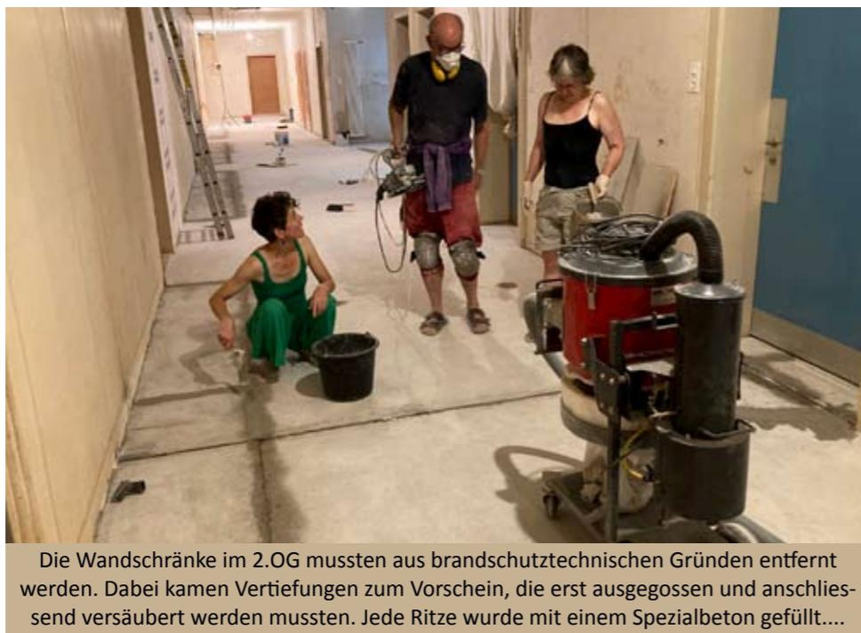
Die Wandschränke im 2.OG mussten aus brandschutztechnischen Gründen entfernt werden. Dabei kamen Vertiefungen zum Vorschein, die erst ausgegossen und anschliessend versäubert werden mussten. Jede Ritze wurde mit einem Spezialbeton gefüllt....
