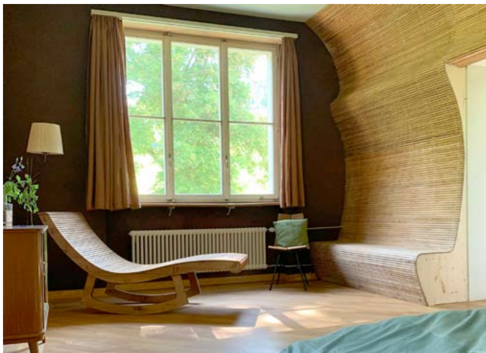
Aufbau der Wand aus den alten Rolläden
