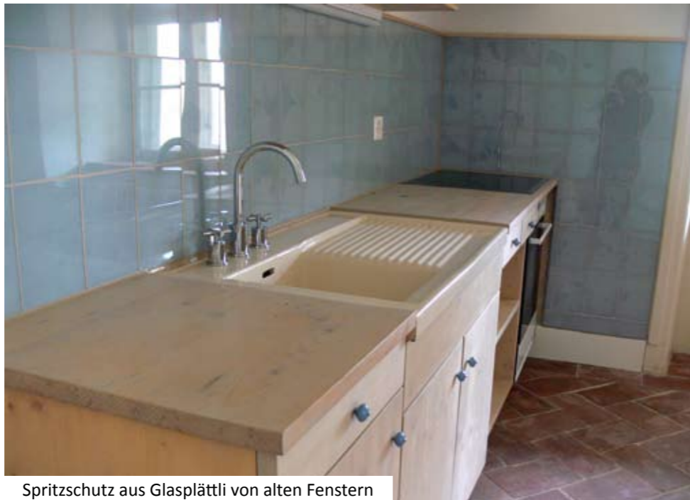
Alte Biberschwanzziegel werden zu einem wunderbar lebendigen Boden verlegt
