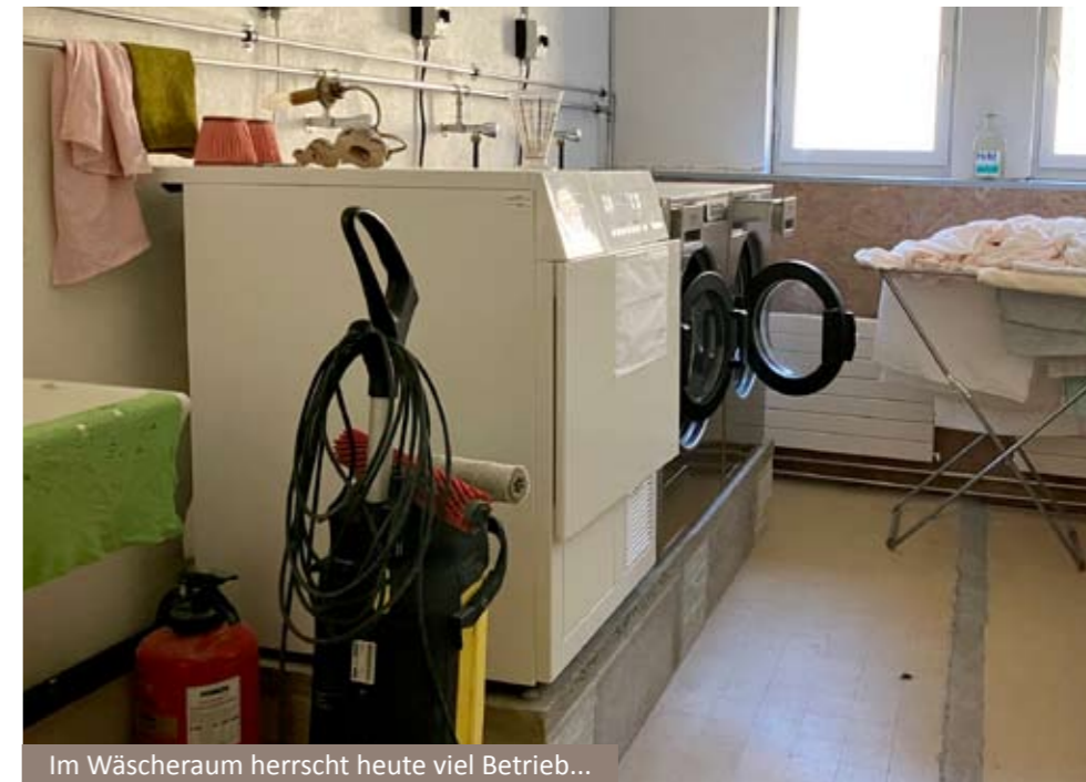
Mit einem Teil der Betonplatten aus dem Garten wurde ein Fundament hergestellt
